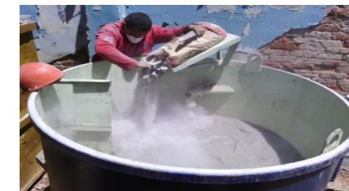
Mezcladoras cap. 1 y 2 m3 preparación de lodo bentonitico
