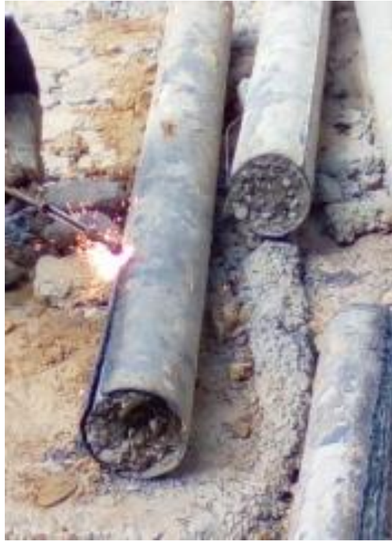
Tubería tremie tapada 2,5 h esperando concreto, asentamiento 7 1/2"
